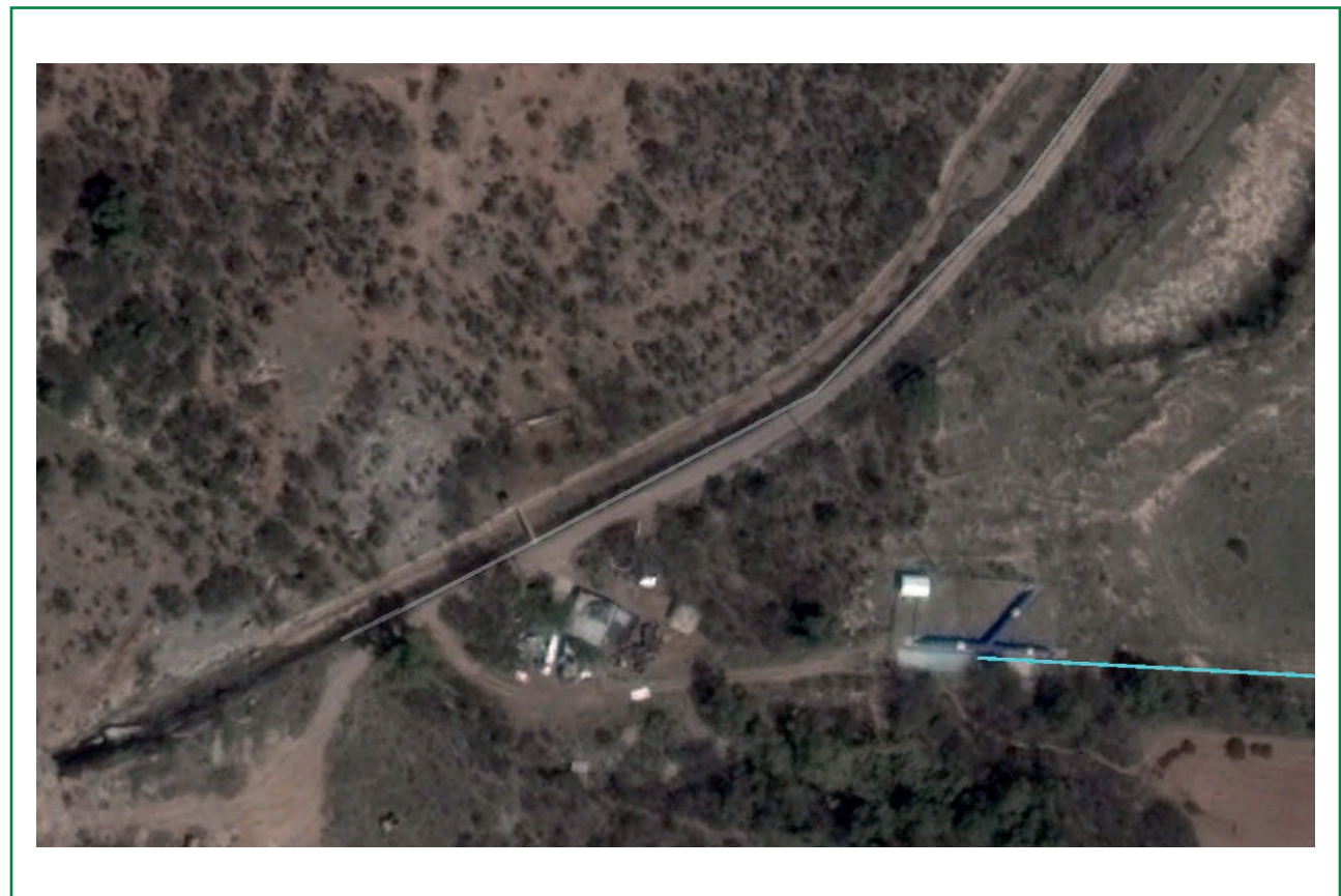
FIGURA 5.3. Ubicación de la salida del túnel que viene de la presa Jocoqui y la bifurcación que abastece al distrito de riego
